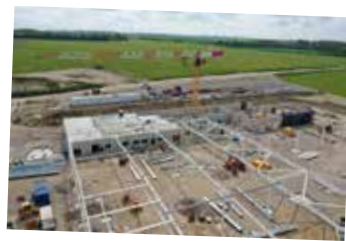
UN GRAND CHANTIER AU CHAMP GRETZ
