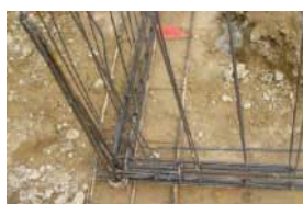
Nœud de chaînage - Continuité mécanique
