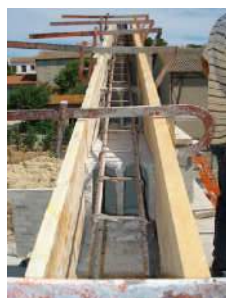
Mise en place d'un chaînage au niveau d'un rampant d'un bâtiment
