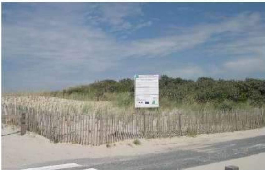
Principe de ganivelles délimitant la route le long de dunes
