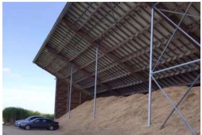
Grange de stockage couverte de panneaux solaires
