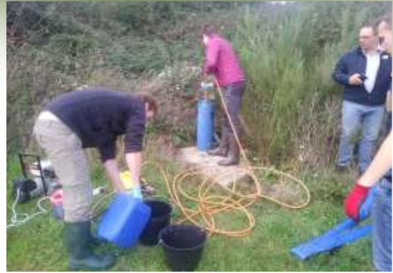
Traçages sur le champ-captant d'Airon-Saint-Vaast – 04/2023 Injection du traceur dilué dans un piézomètre
