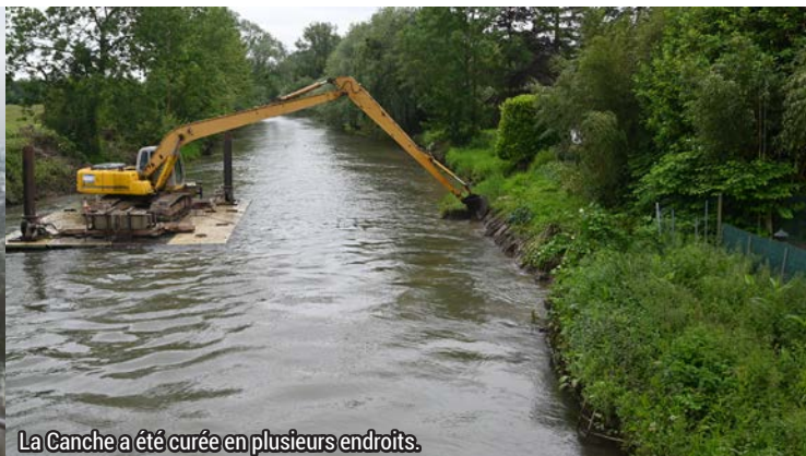
Des tonnes de sable ont été acheminées dans de nombreuses communes.
