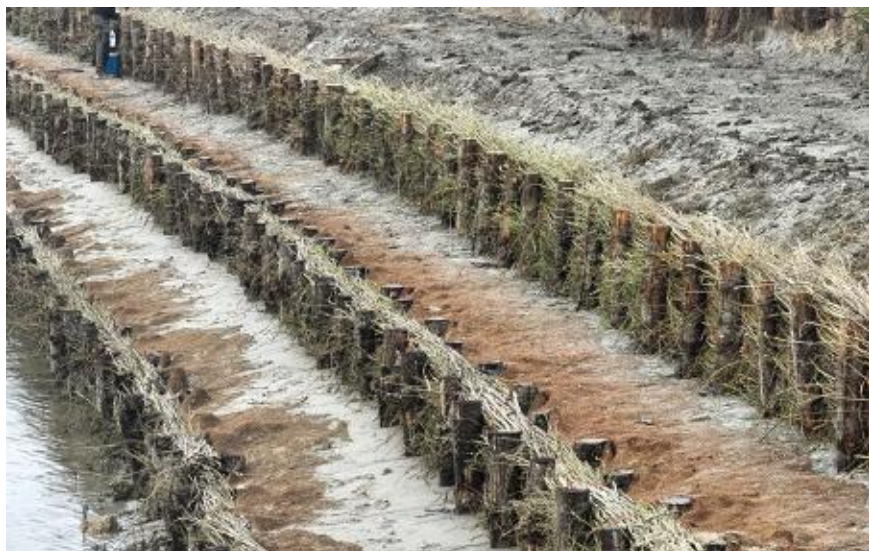
Aménagement de fascines au Coude de La Molière à Groffliers
