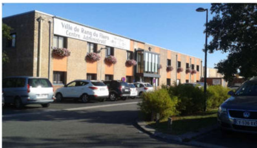
vue 1 : vue sur le centre administratif
