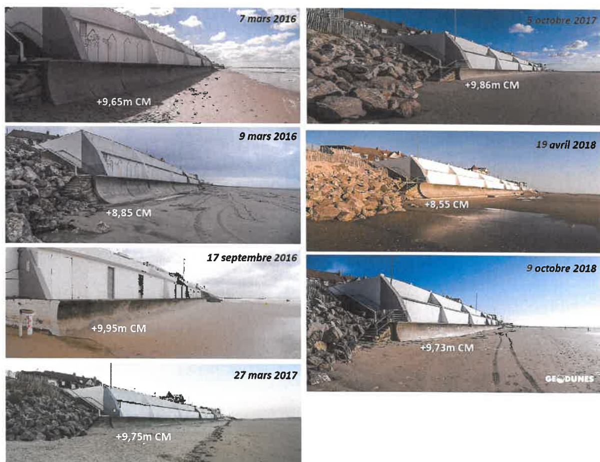
Figure 1: Evolution de l'altitude de la plage au pied du perré de Merlimont entre 2016 et 2017.
