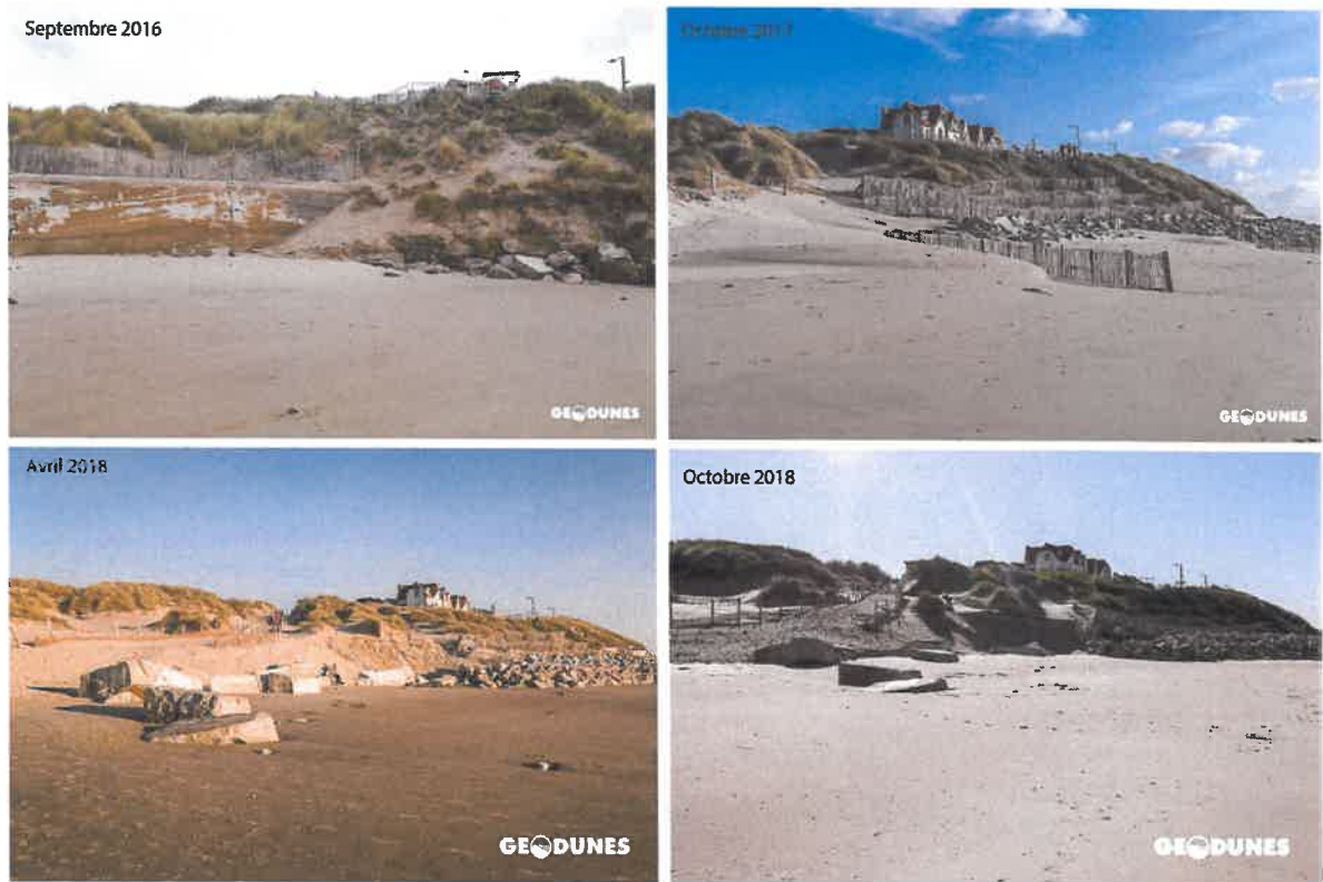
Figure 2: Situation de la plage devant le belvédère entre septembre 2016 et octobre 2018. L'érosion est marquée juste au contact entre la dune et les enrochements.
