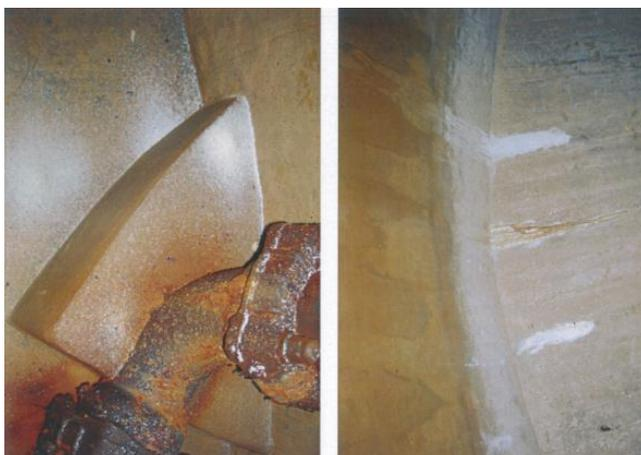
Cuve de droite : Des infiltrations et fissures ont été observées → à surveiller
