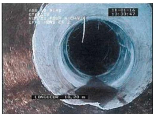
✓ Le 10 août, suite à l'orage, un mouvement de chaussée a été observé **rue des Molières**. Le contrôle du collecteur EP réalisé le lendemain n'a pas montré de section endommagée, et l'écoulement des eaux de pluies était correct. Néanmoins, il a été constaté un ensablement important nécessitant un curage du réseau.
