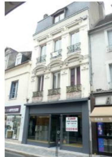
AP6: photo de l'immeuble dans son ensemble
