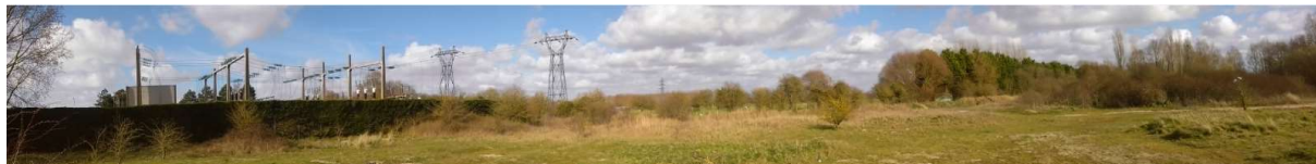
vue 2 : sur la centrale électrique en place
