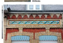
Montage photo : des lambrequins (en métal ou en bois) masquent les coffres de volets roulants + moyen efficace, simple à mettre en oeuvre, et peu onéreux pour remettre en valeur une façade qui possède des coffres de volets roulants apparents.
